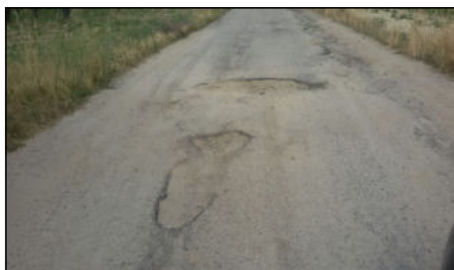
Scorcio di una strada in zona Campo Vile
