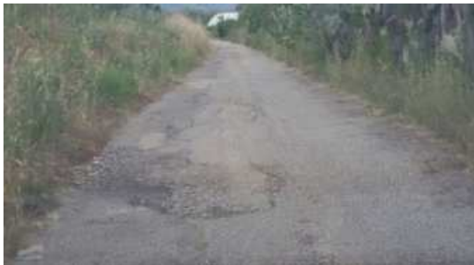
Strada dissestata in zona Campo Vile
